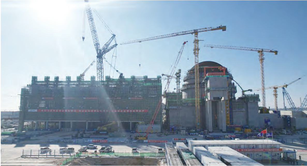
正在建设中的徐大堡核电3号机组
