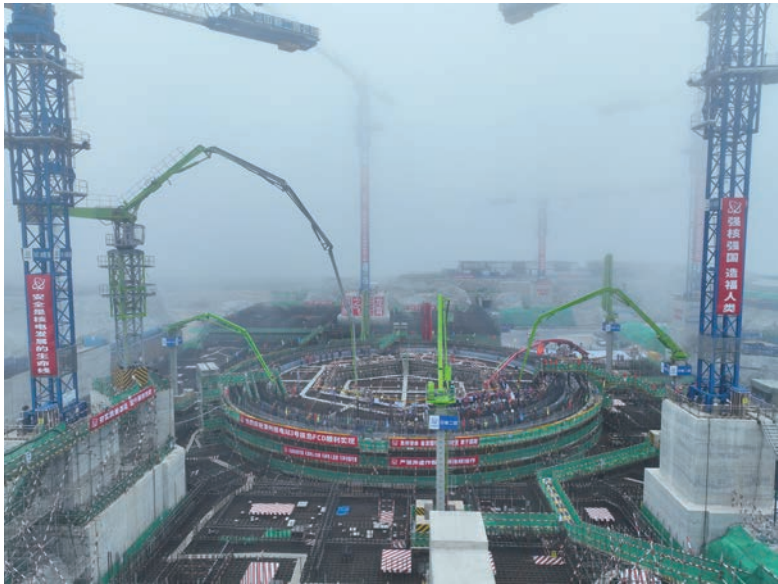
漳州核能3号机组开工
